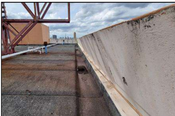
รูปที่ 2-14 รางระบายน้ำรอบอาคารบริเวณชั้นดาดฟ้า
