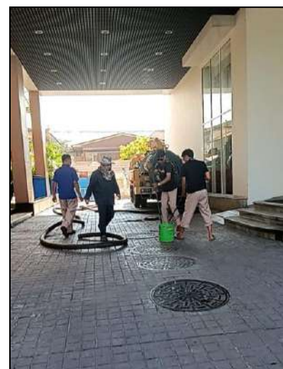
รูปที่ 2-10 การดูแล บำรุงรักษา และสูบน้ำออกจากระบบบำบัดน้ำเสีย
