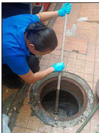
รูปที่ 2-10 การดูแล บำรุงรักษา และสูบน้ำออกจากระบบบำบัดน้ำเสีย
