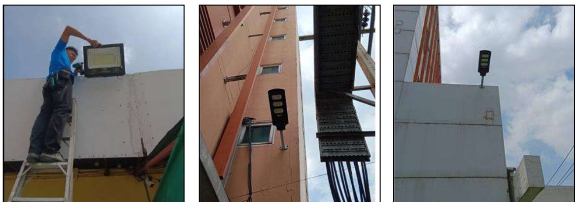
รูปที่ 2-12 การใช้หลอดไฟ LED และโซลาร์เซลล์
