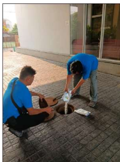
รูปที่ 2-10 การดูแล บำรุงรักษา และสูบน้ำออกจากระบบบำบัดน้ำเสีย
